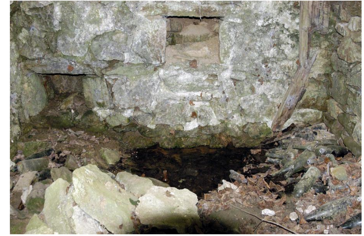
Source du Barsac à Dore l'Eglise. Captage sous abri voûté et fermé.
