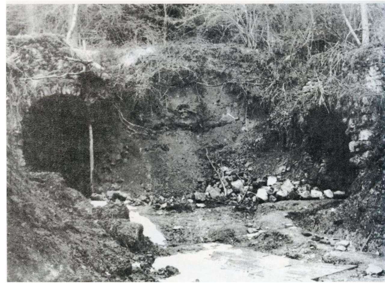
Réservoirs construits pour 3 griffons
