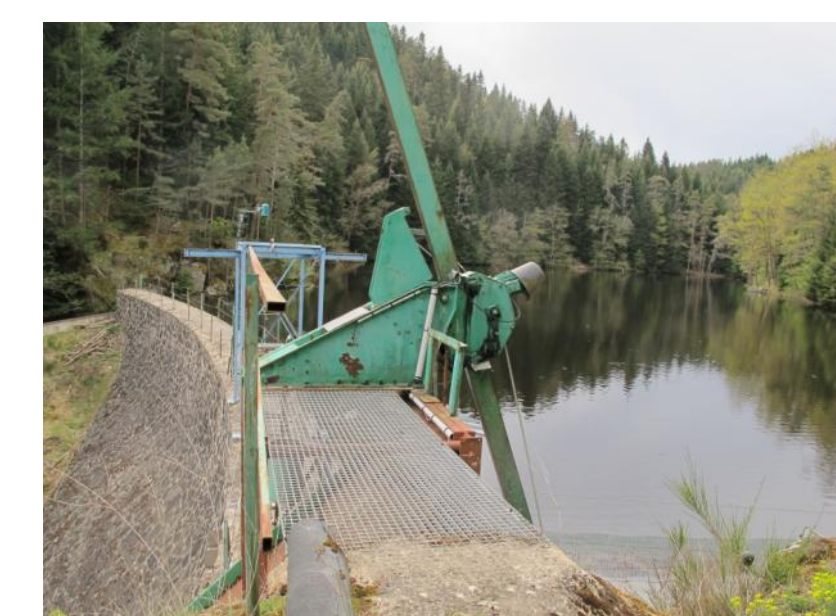
Le barrage et le lac aujourd'hui. Commande de la vanne de prise d'eau. - Photo Francine Chommy
