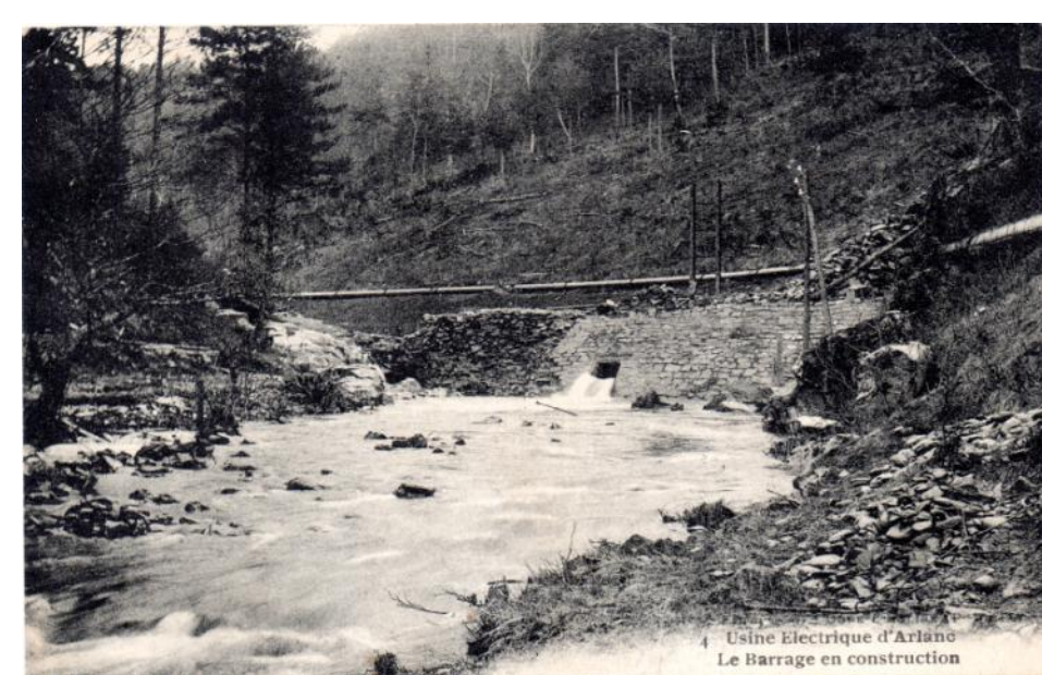
Le barrage en début de construction. La 1ère usine continue d'être alimentée par la conduite forcée du 1er barrage qui chemine à flanc de coteau. Carte - Collection F. Chommy
