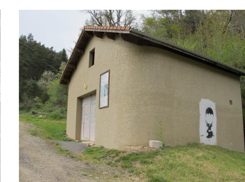
Le bâtiment de la nouvelle centrale électrique - Photo Francine Chommy
