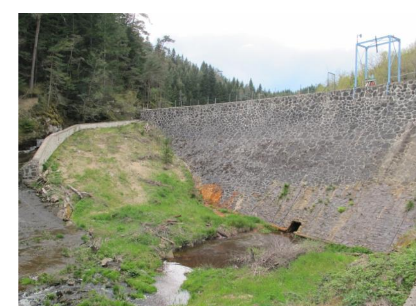
Le barrage côté aval. A gauche le déversoir et la passe à poissons. Au pied du mur, l'orifice de vidange. Photo Francine Chommy
