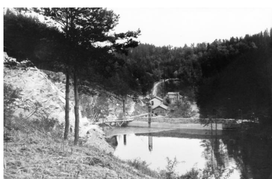
Le barrage en construction. La conduite forcée passe au-dessus du mur. Editions Louis Boy AD du Puy-de-Dôme - Photothèque 63 - 501-FI 706
