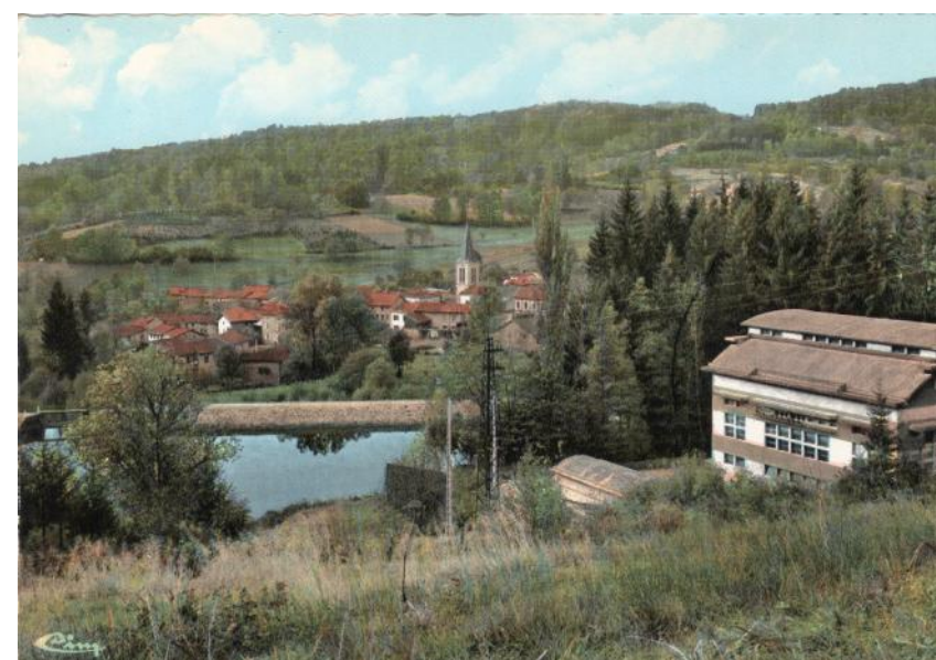
La centrale de Grandrif au-dessus du réservoir de la centrale de Barrot. Carte Cim Collection Francine Chommy
