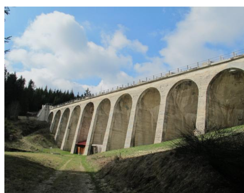
Le barrage côté aval. Sous la 5e voûte partent les tubes de vidange et la conduite forcée vers la centrale de Grandrif. Photo Francine Chommy
