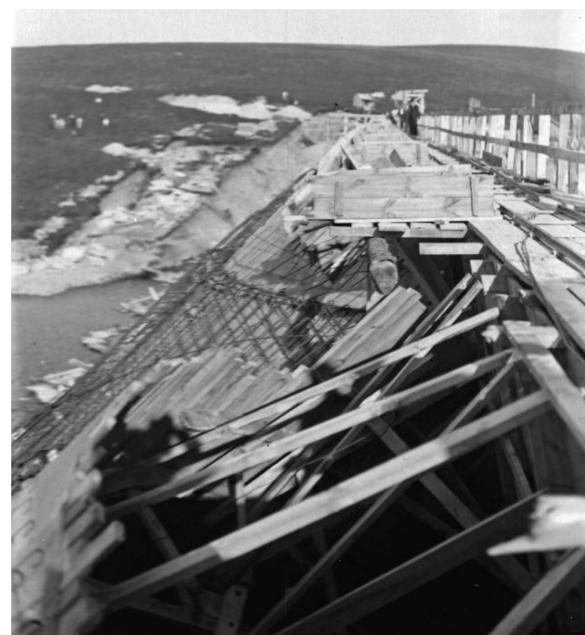
Le barrage en construction. Ferrailage des voûtes en béton sur le 1er coffrage en forme. Au sommet, une voie « Decauville » pour le transport des wagonnets à béton. Photo Jean Gouffefangeas - Ed. Gd'O AD du Puy-de-Dôme - Photothèque 63 - 575-FI 311
