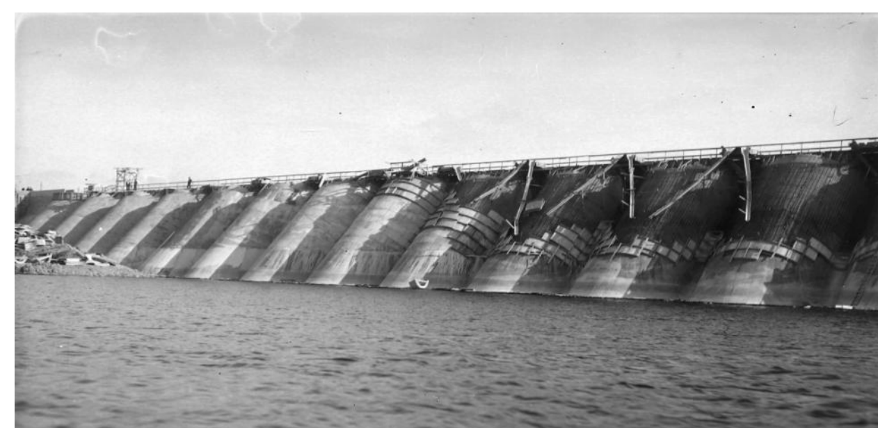
Le barrage en construction. Mise en place du 2e côté du coffrage en forme par-dessus le ferrailage. Le béton sera coulé au moyen des conduits mobiles qui partent du sommet. Photo Jean Gouffefangeas - Ed. Gd'O AD du Puy-de-Dôme - Photothèque 63 - 575-FI 310
