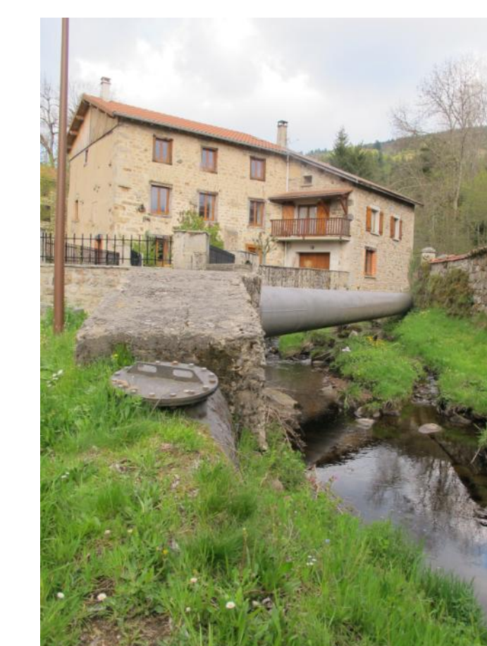
Grandrif. La conduite forcée en aval du réservoir vers la centrale de Barrot. Photo Francine Chommy
