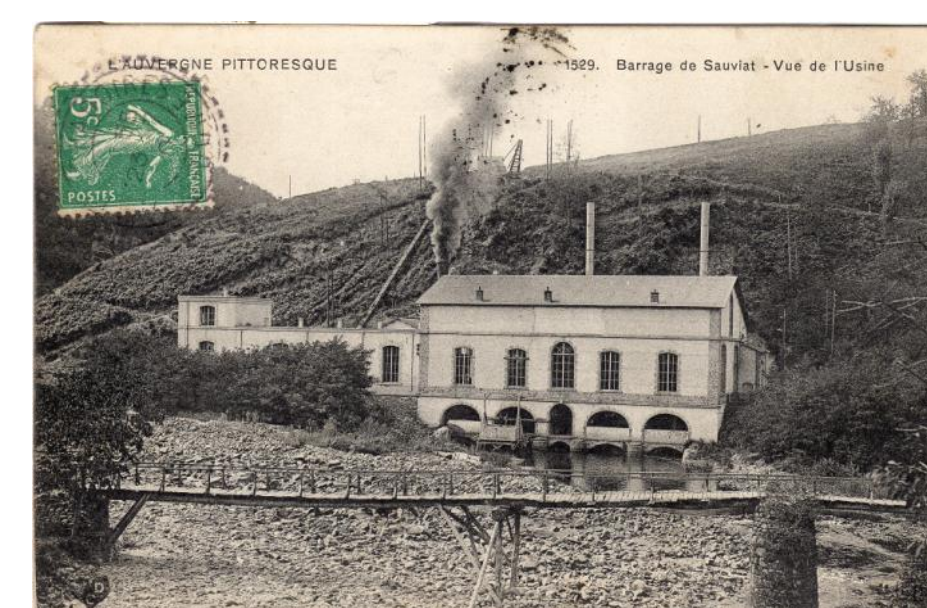
L'usine électrique est complète. La machine à vapeur est en service. Le charbon est déversé dans une goulotte descendant du sommet de la colline. Carte - Collection Francine Chommy
