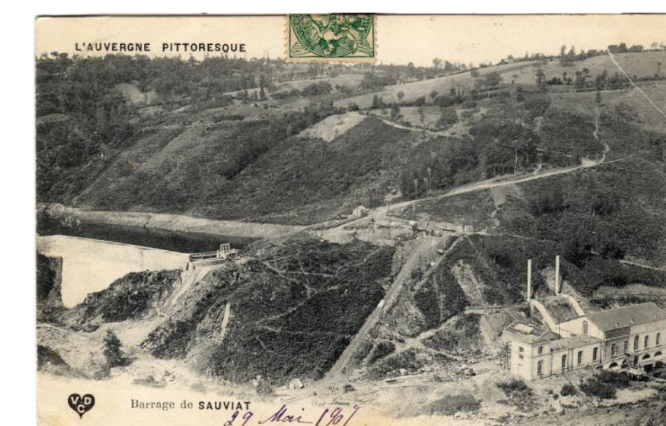
Vue générale du chantier de construction de l'extension de l'usine électrique (à droite). A gauche, le barrage avec la coulée du déversoir de crue à sa droite. Au centre, le funiculaire avec un wagonnet à mi-côte. - Carte - Collection Francine Chommy
