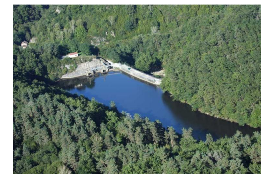
La retenue de la centrale de Sauviat. Vers la droite, le barrage. Vers la gauche, adossé à la colline, le mur évacuateur de crue avec les prises d'eau des conduites forcées. Photo Adoclub du Livradois-Forez Site Internet
