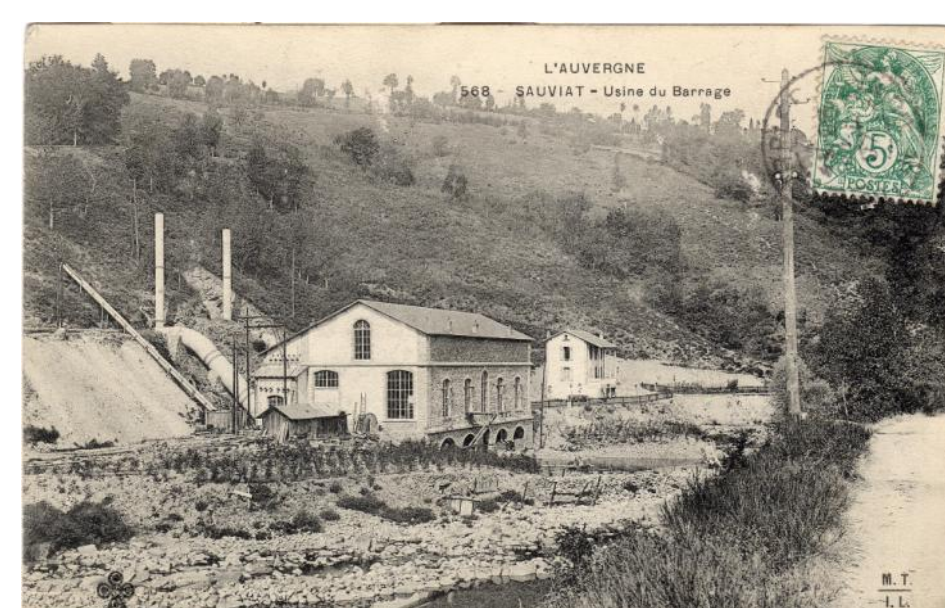
L'usine électrique est terminée, les conduites forcées avec leur reniflard sont installées. A l'arrière, le bâtiment du transformateur avec les départs des câbles. Carte - Collection Francine Chommy
