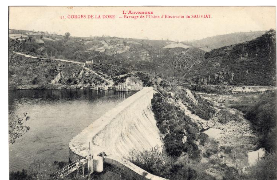
Le barrage. Au fond le mur évacuateur de crue avec les commandes des vannes de prise d'eau. Au premier plan, l'arrivée du canal de dérivation de la Dore dont une partie chemine sur la crête du barrage. Carte - Collection Francine Chommy
