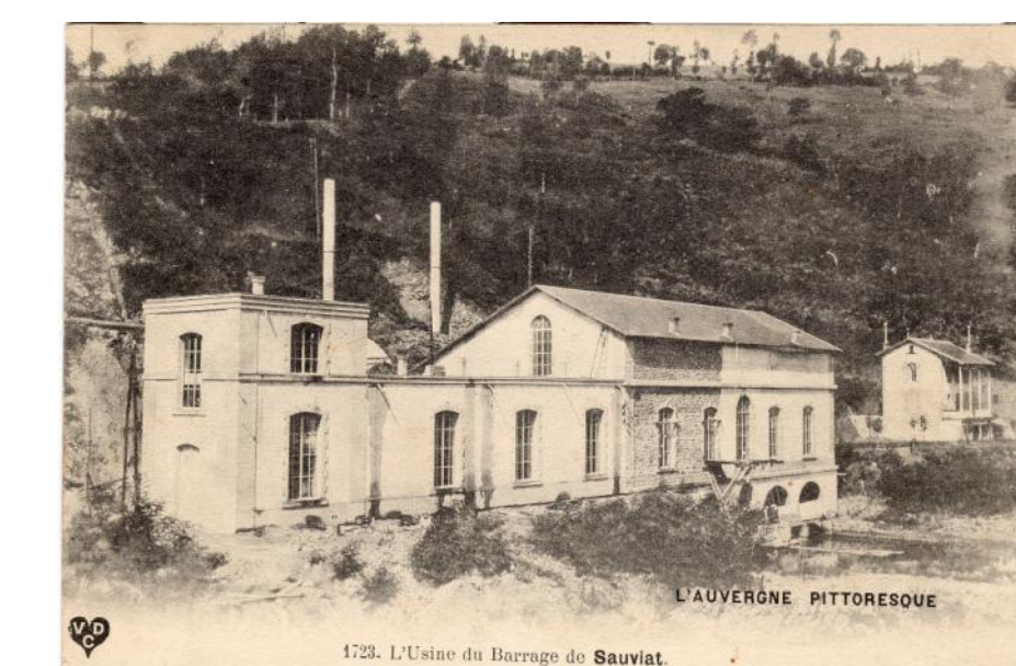
Vue générale de l'usine électrique. Carte - Collection Francine Chommy
