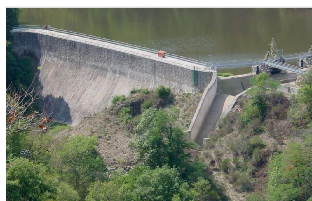
Le barrage vu d'aval. A droite, l'évacuateur de crue et son déversoir avec les commandes des vannes de prise d'eau des conduites forcées. Photo Cédric Proust - Site Internet L'Isle-sur-Dore
